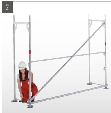
2 Vertikaldiagonale montieren, Horizontalstrebe einbauen (nur im Diagonalfeld).
